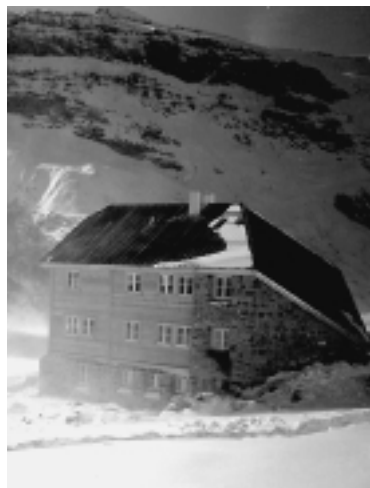
SAC-Lämmernhütte, 2507 m ü. M
