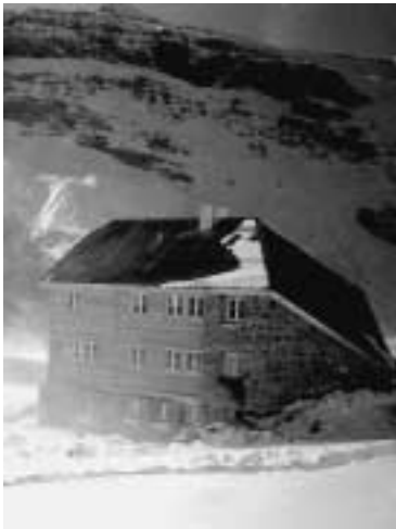
SAC-Lämmernhütte, 2507 m ü. M
