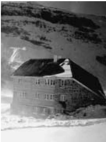
SAC-Lämmernhütte, 2507 m ü. M
