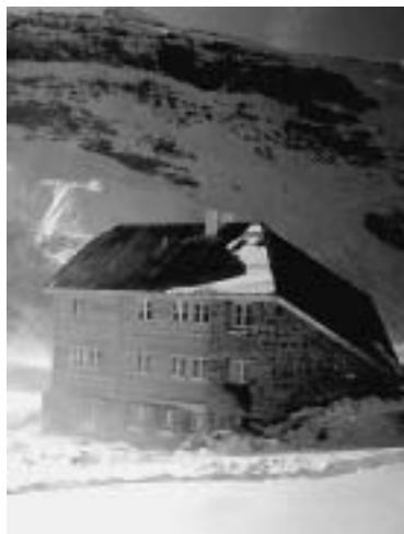
SAC-Lämmernhütte, 2507 m ü. M
