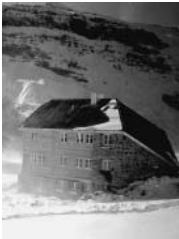
SAC-Lämmernhütte, 2507 m ü. M
